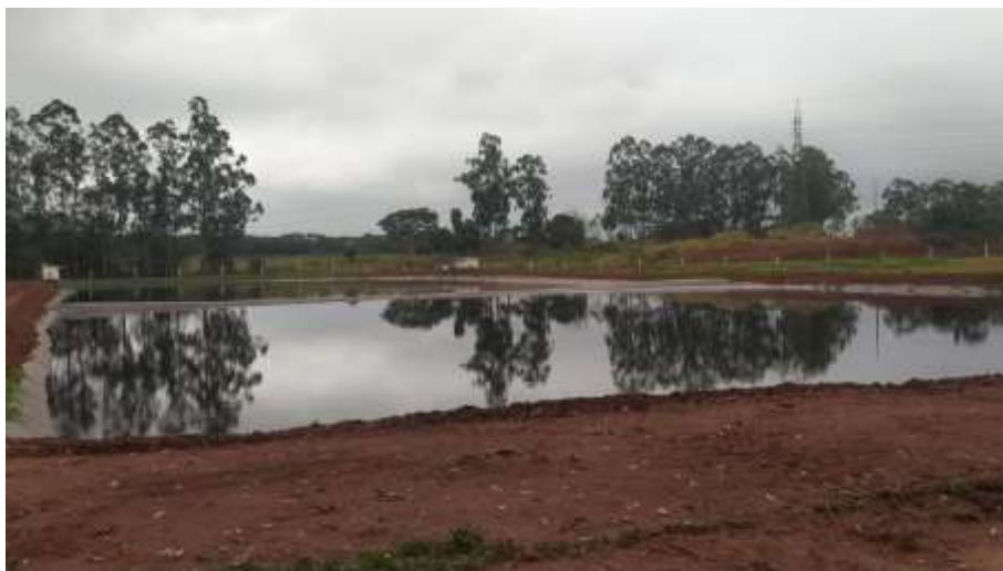
Figura 8 – Lagoas de estabilização para tratamento de chorume gerado no aterro municipal
