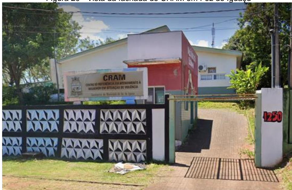
Figura 20 - Vista da fachada do CRAM em Foz do Iguaçu
