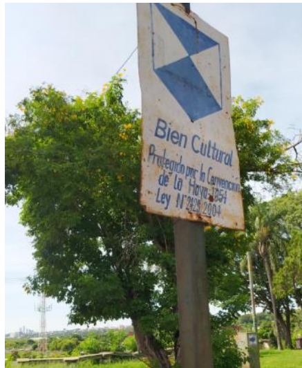
Figura 11: Efecto de oxidación
