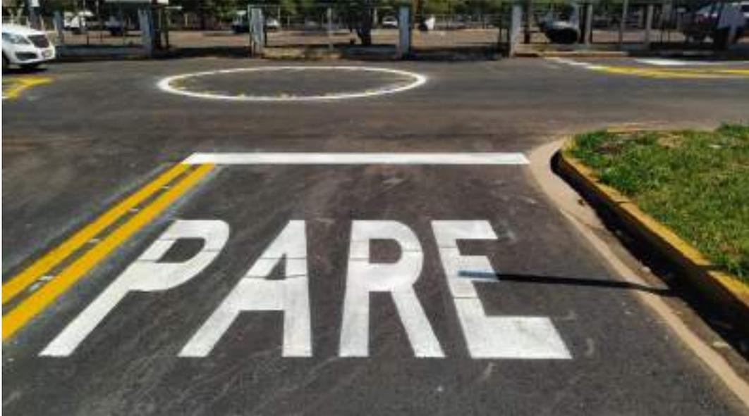
**Figura 5:** Señalización Horizontal de Control de Tráfico en Pavimento.
