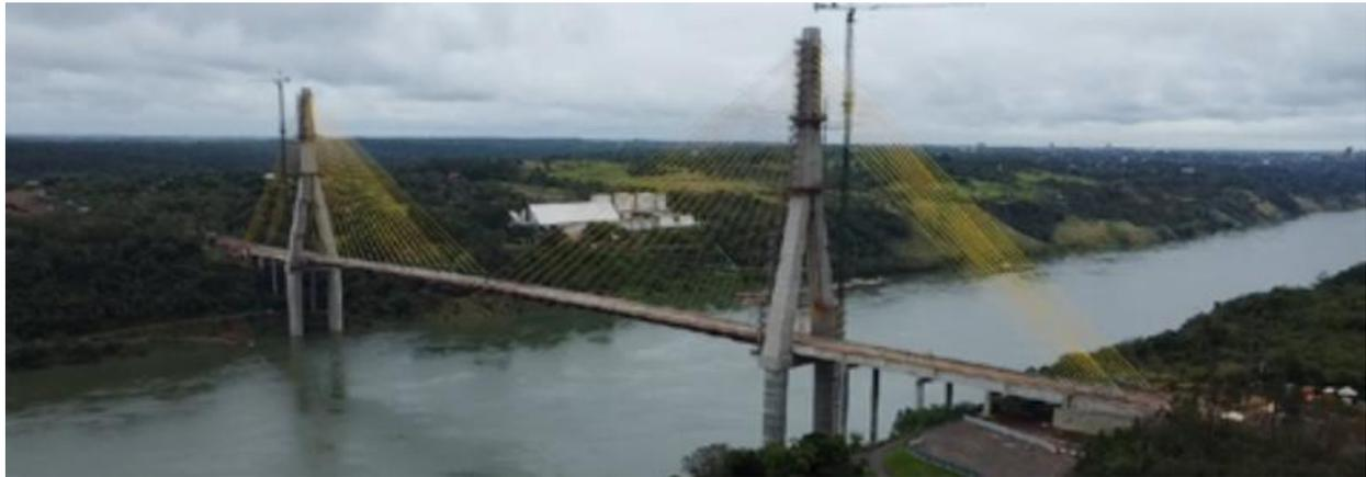
Figura 4: Vista da Ponte após a união do vão central. Fonte: Consórcio Ponte Brasil Paraguai, 2022.
