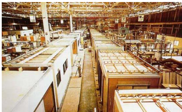
Figura nº 7. Linha de produção da construção por módulos.
