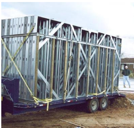
Figura nº 6. Montagem pelo método por painéis.
