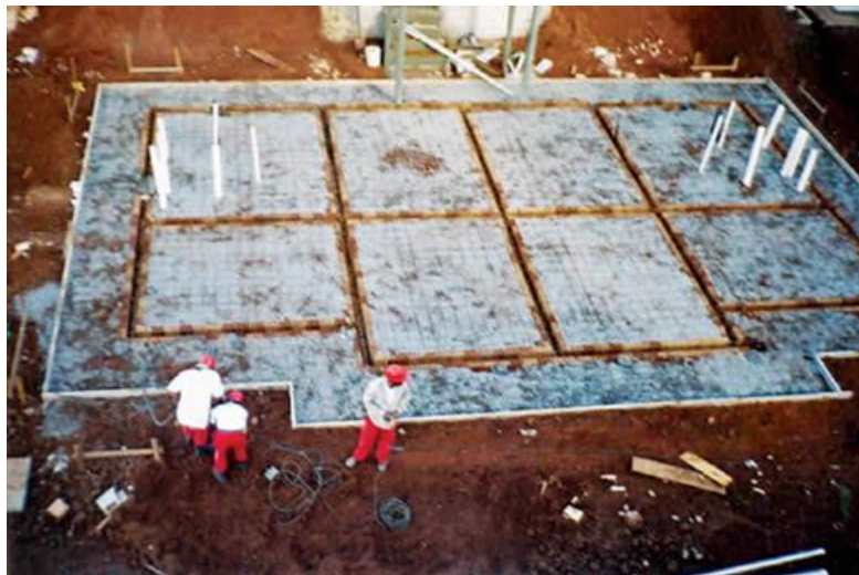
Figura nº 39. Exemplo da tubulação na etapa de fundação.
