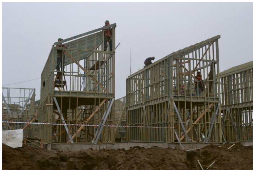
Figura nº 76. Execução da estrutura em Wood Frame nas casas de Villa Verde.
