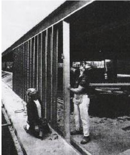
Figura nº 5. Montagem pelo método Stick.
