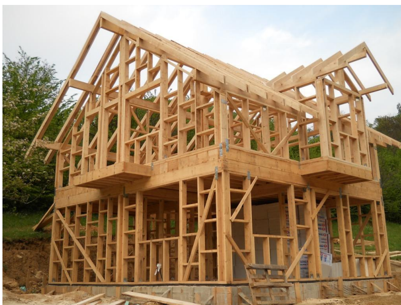
Figura nº 1. Estrutura em Wood Frame .
