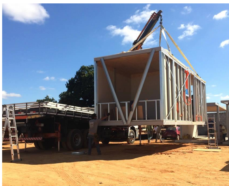
Figura nº 65. Módulos da Casa Chassi sendo colocados no canteiro de obras.
