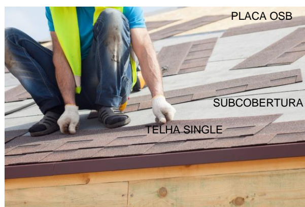
Figura nº 46. Exemplo de telhado em telha shingle.
