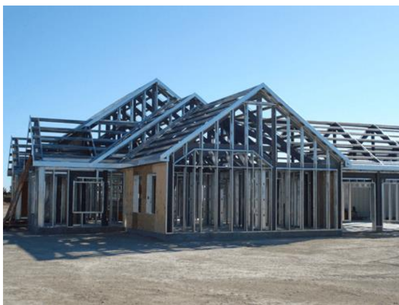
Figura nº 2. Estrutura em Light Steel Framing .
