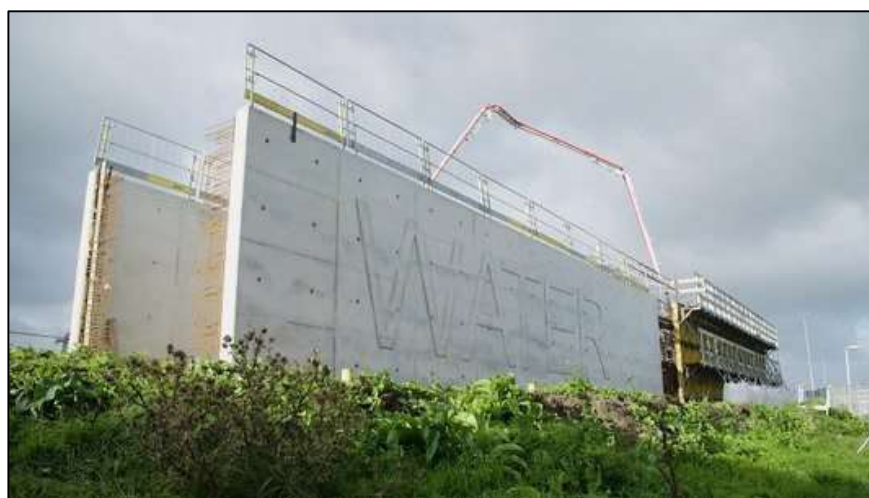
Figura 2: Tanque de água com 47 metros de comprimento, 5,5 metros de largura e 5 metros de altura, com duas paredes construídas com concreto simples, e duas construídas com a adição do Basilisk Healing Agent
