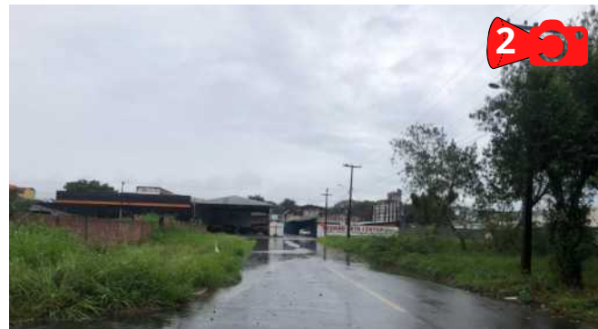
Foto trecho 1: Alagamento Rua Clara Nunes
