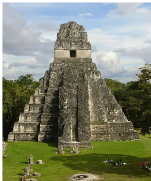
Figura 12 – Pirâmide de Tikal (Guatemala), com suas paredes em “apique bruto de pedra” calcária
