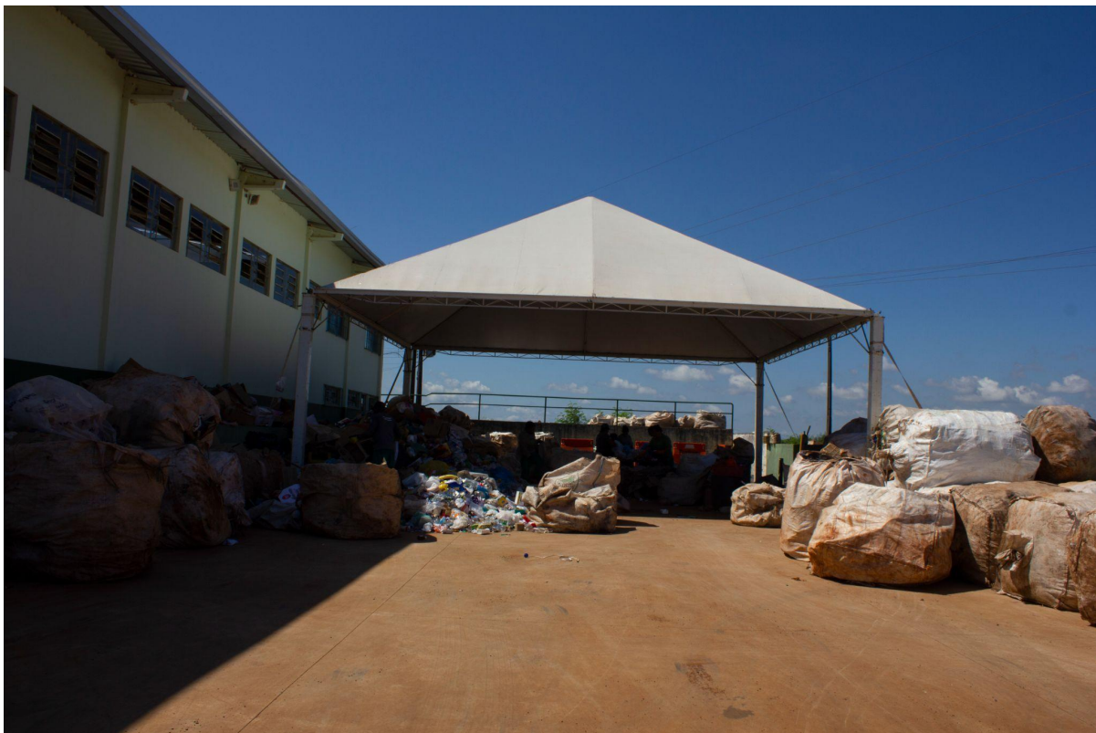
Foto- Tenda do lado do Galpão de Porto Belo - Registro do Autor- Dezembro de 2022
