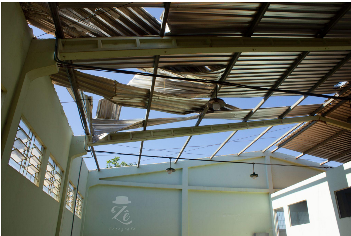
Foto- Telhado do Galpão de Porto Belo - Registro do Autor- Dezembro de 2022
