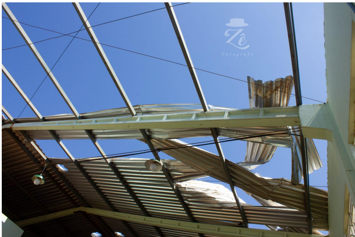
Foto- Telhado - Registro do Autor- Dezembro de 2022
