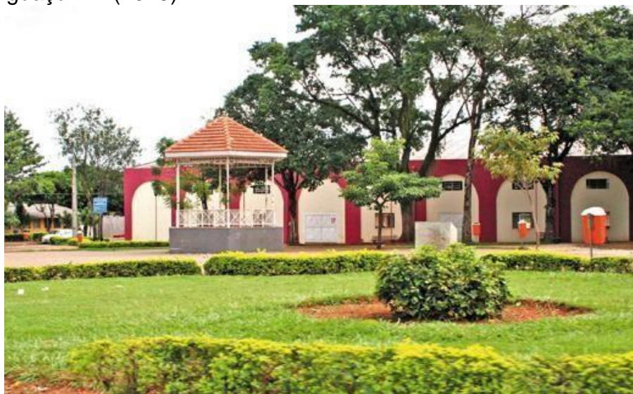
Figura 1 - Fotografia ilustrativa da fachada do Centro de Convivência do Idoso (CCI) de Foz do Iguaçu-PR (2019)
