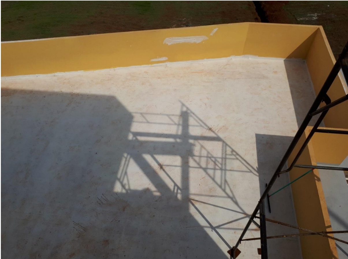
Figura 3.29. Laje em CLT impermeabilizada
