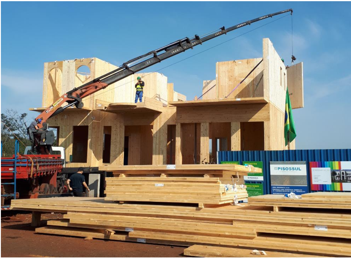
Figura 3.12. Imagem da execução da obra em CLT - Foz do Iguaçu-PR
