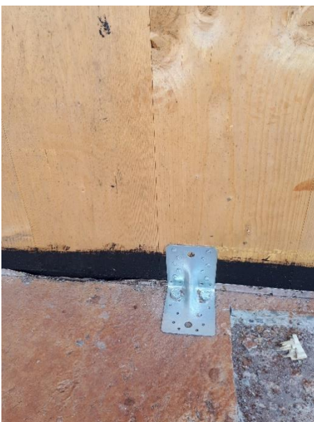
Figura 3.23. Conexão entre painel vertical e radier
