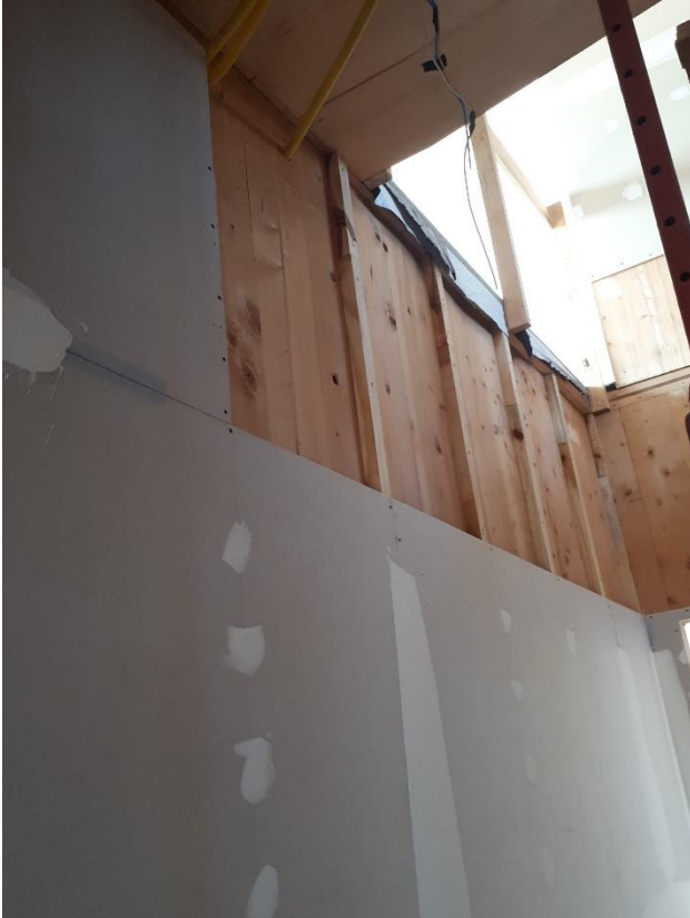
Figura 3.35. Parede com barrotes, eletroduto corrugados e drywall
