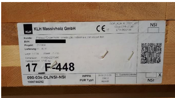
Figura 3.17. Etiqueta de identificação do painel para laje em CLT
