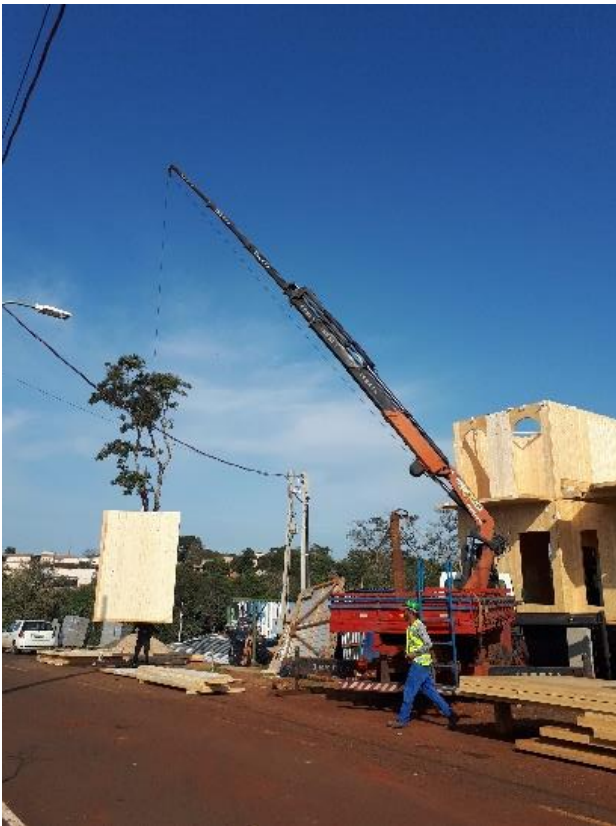
Figura 3.15. Painel CLT içado pelo guindaste
