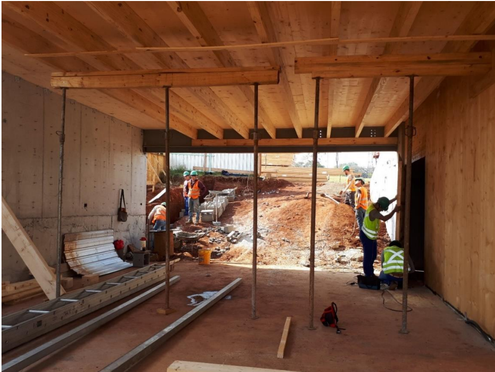
Figura 3.22. Escoras sustentando a laje de cobertura do subsolo
