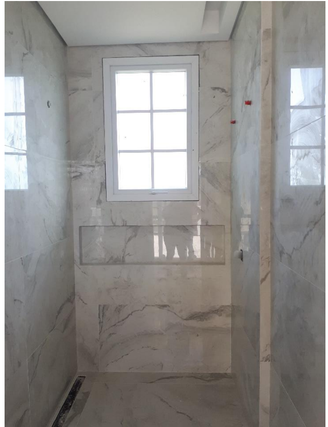
Figura 3.40. Etapa de acabamentos banheiro
