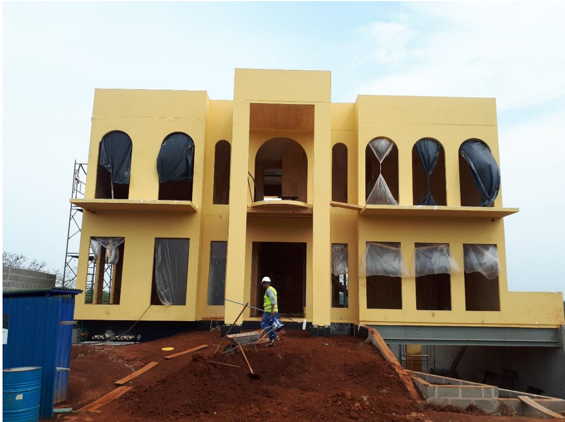
Figura 3.28. Fachada principal com membrana impermeável (pintura amarela)
