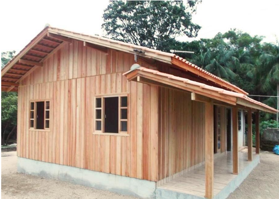
Figura 3.4. Edificação no sistema construtivo em tábuas e mata-juntas
