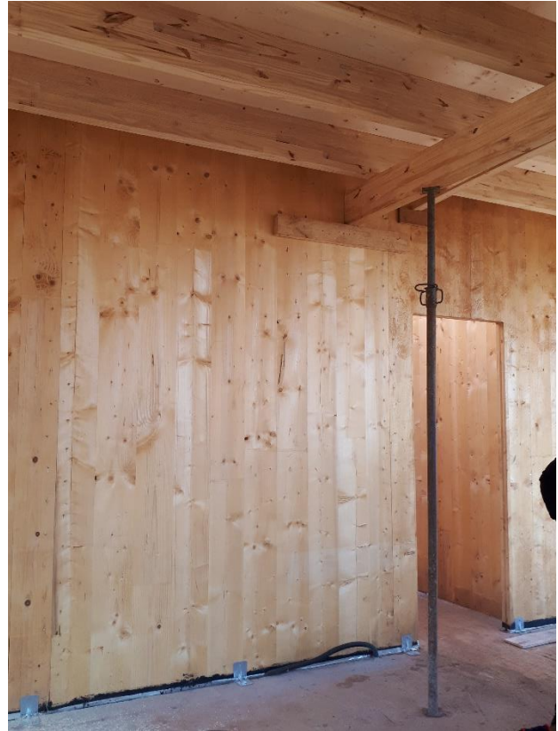
Figura 3.27. Painéis CLT instalados sobre chapa de aço
