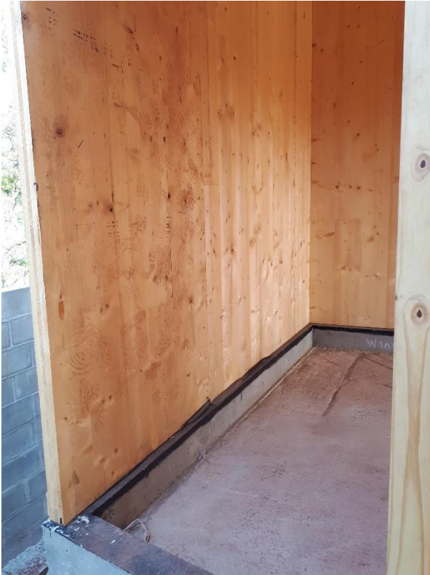
Figura 3.26. Painéis CLT instalados sobre vigas de baldrame
