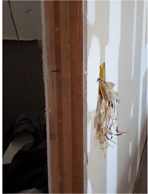
Figura 3.36. Parede com barroto em uma das faces para passagem de eletroduto corrugado
