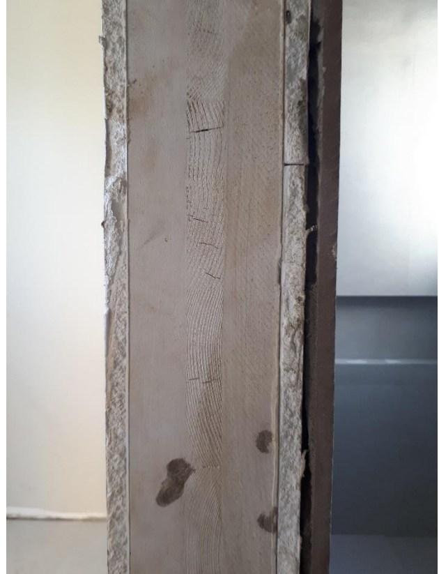
Figura 3.38. Parede interna sem barrotes e com drywall em uma face e drywall e revestimento cerâmico na outra face
