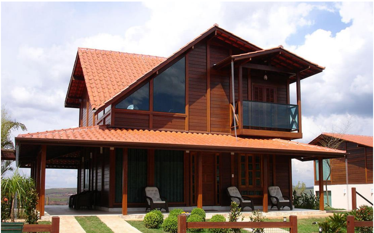
Figura 3.7. Edificação no sistema de encaixe macho fêmea
