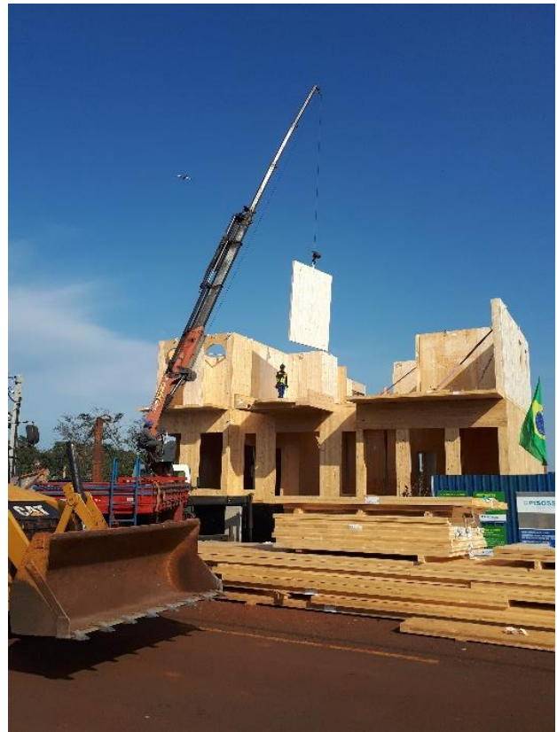
Figura 3.16. Montagem do painel CLT na obra
