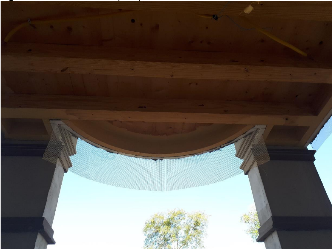
Figura 3.42. Detalhe fachada principal com EPS e tela de fibra de vidro
