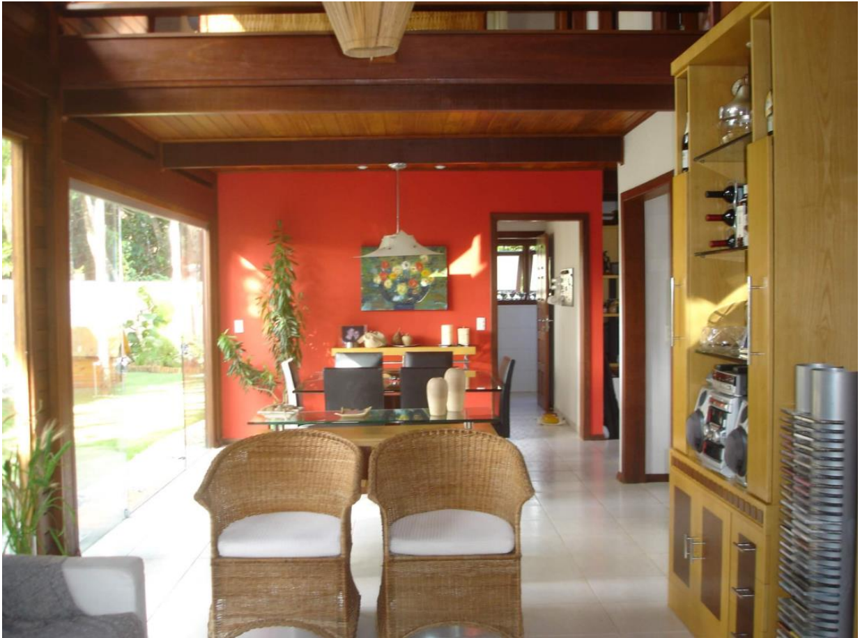
Figura 3.6. Edificação no sistema misto em madeira e alvenaria
