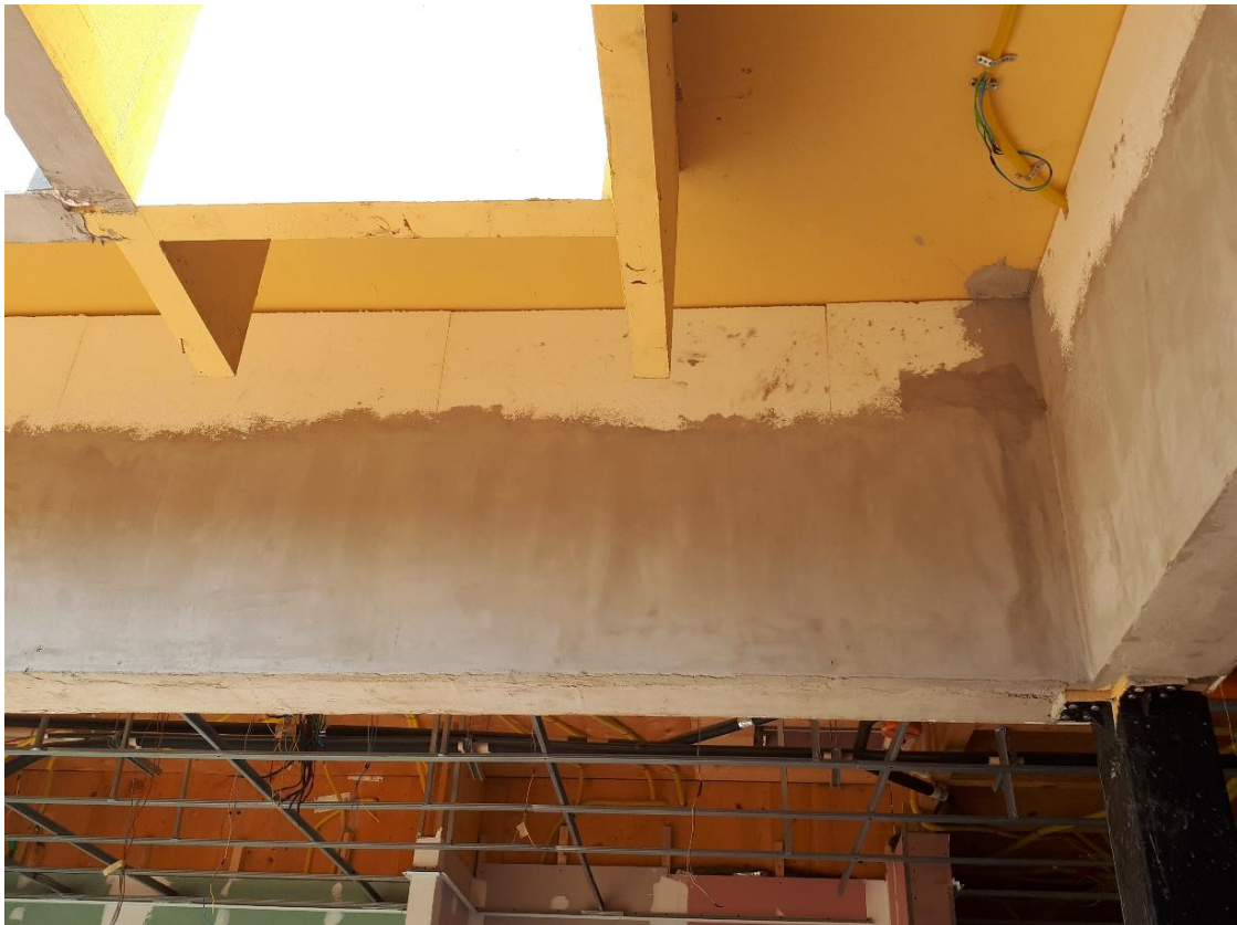
Figura 3.41. Aplicação de EPS e argamassa paredes externas
