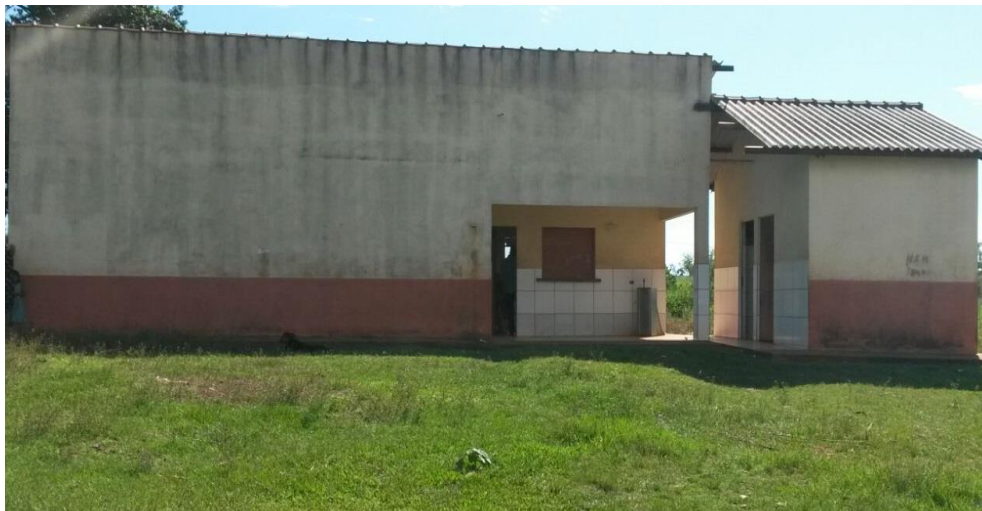
Foto 6 Nova construção da extensão Ana Neri Fonte: Imagem nossa
