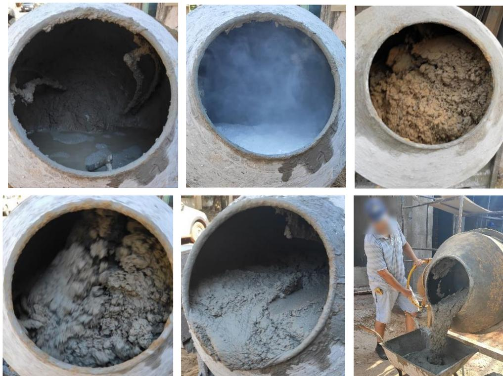
O volume de argamassa produzido em cada betonada foi calculado pelo traço coletado em obra. O volume de argamassa produzido por dia foi determinado através do produto entre o número de betonadas/dia produzidas na obra pelo volume de argamassa produzida em cada betonada. O número de betonadas/dia foi definido pela da média de três dias de coleta.
