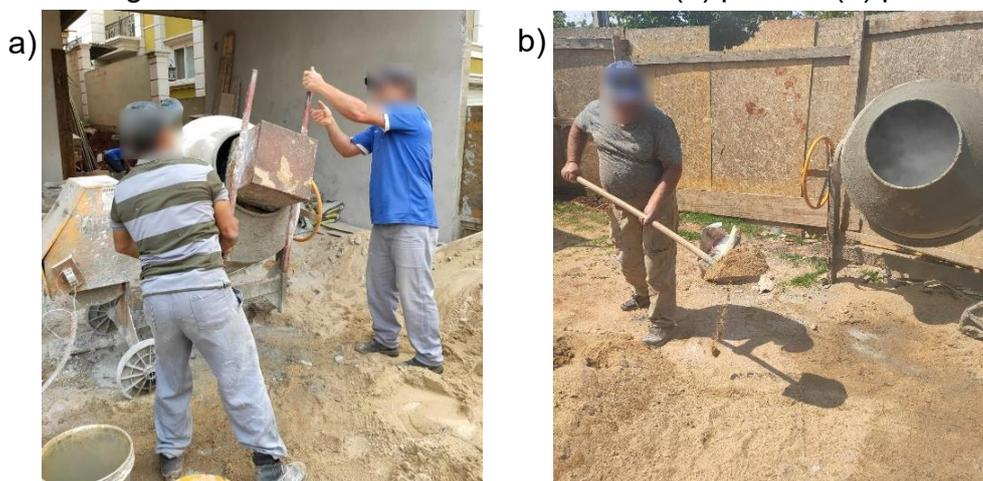
O processo de mistura da argamassa foi acompanhado e validado de forma visual conforme Figura 2.3, identificando a ordem e a quantidade de materiais inseridos na betoneira. O tempo de mistura foi cronometrado desde que a betoneira foi ligada até o momento em que a mesma foi desligada.
