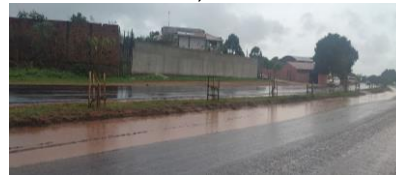
Figura 13. Acúmulo de água no canteiro leste, no Trecho BC.
