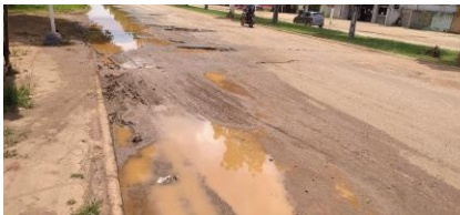
Figura 7. Pista principal no Trecho AB.
