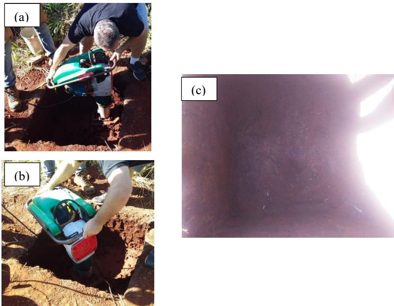
Figura 28 – Compactación del suelo de la base de la zapata. (a) (b) Procedimiento de compactación de las bases de las zapatas. (c) Base de la zapata compactada.
