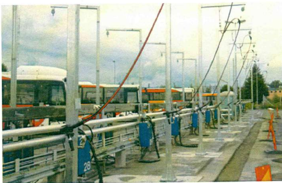
FIGURA 6: Estación de abastecimiento de biogás para buses de servicio público en la región de Östergötland, Suecia.
