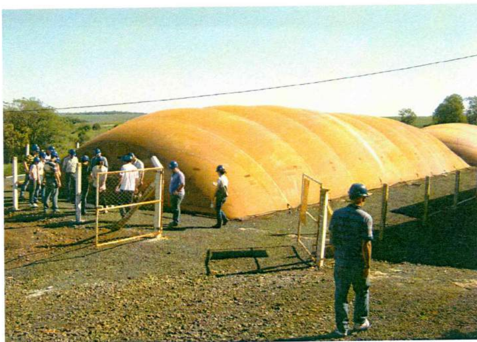
FIGURA 4: Bio-digestores de laguna cubierta
