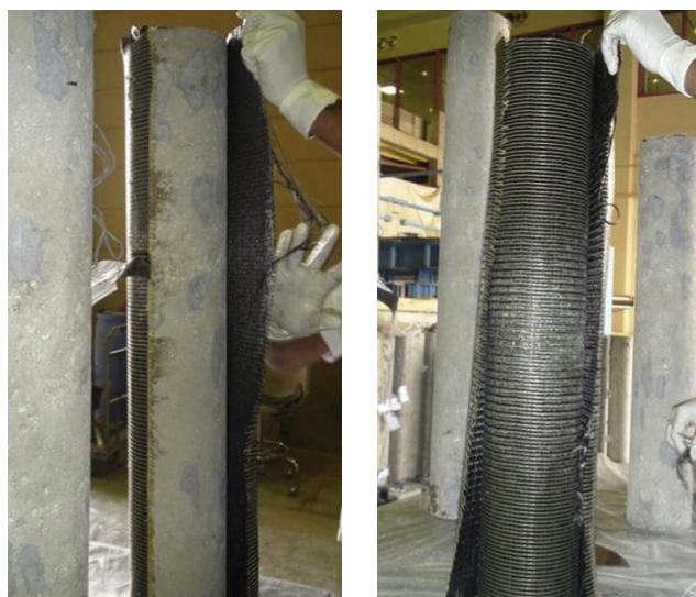
Figura 2-8 - Colagem da manta de CFRP de Siddiqui et. al. (2014): (a) Aplicação da primeira camada de manta de CFRP e (b) Aplicação da segunda camada de manta de CFRP
