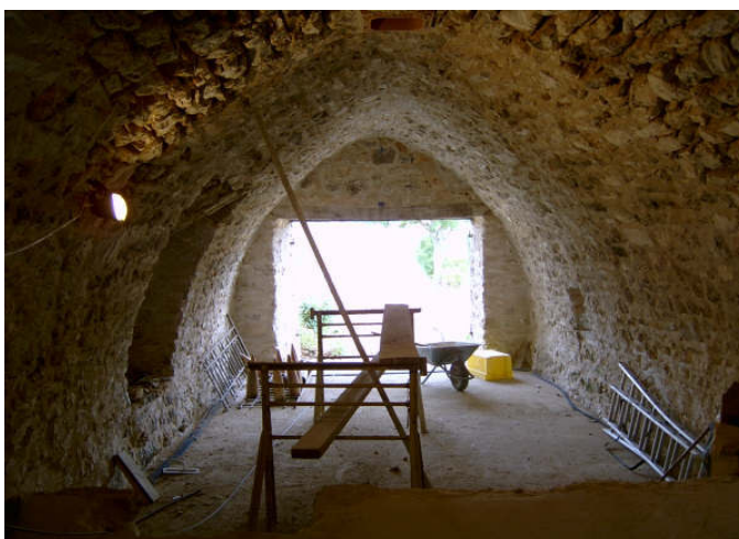
Foto 20: Construção baseada nos padrões "cévenoles" de habitação 144
