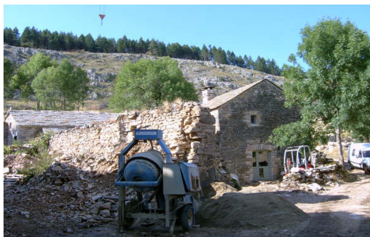
Foto 22: A obra em Frémat já dura 1 ano por conta da dificuldade em transportar material
