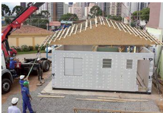
Figura 12. Montagem de unidade habitacional, residencial Haragano, em Pelotas-RS.
