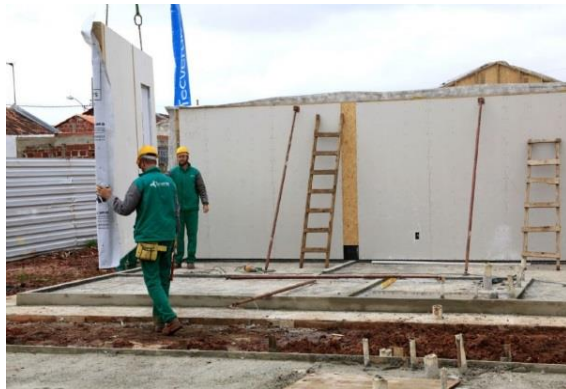
Figura 14. Montagem de unidade habitacional. Condomínio Moradias Nilo, Curitiba-PR. Fonte: AMORIM, 2015.
