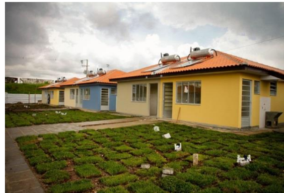
Figura 15. Unidades habitacionais finalizadas. Condomínio Moradias Nilo, Curitiba-PR. Fonte: AMORIM, 2015.
