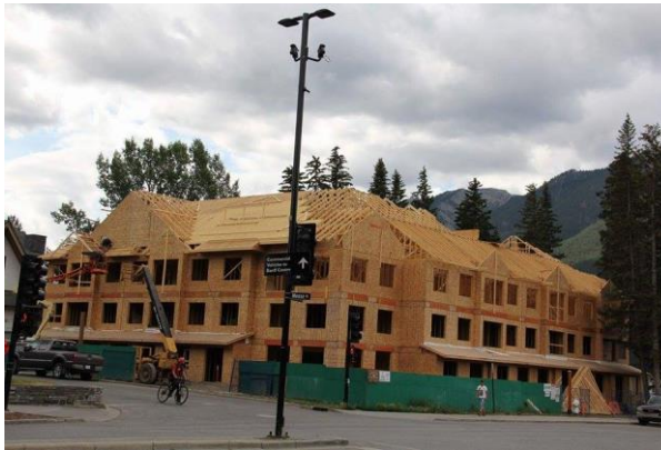
Figura 8. Construção em “ Wood Frame ” na cidade de Banff no Canadá.
