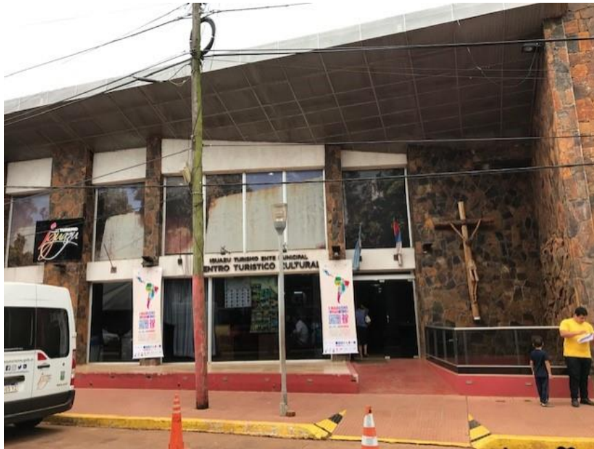
Fotografia 1 - Fachada onde o Departamento de Informática está lotado
