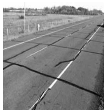
Figura 5. Trincas térmicas
