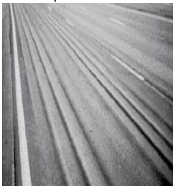
Figura 3. Deformação permanente
