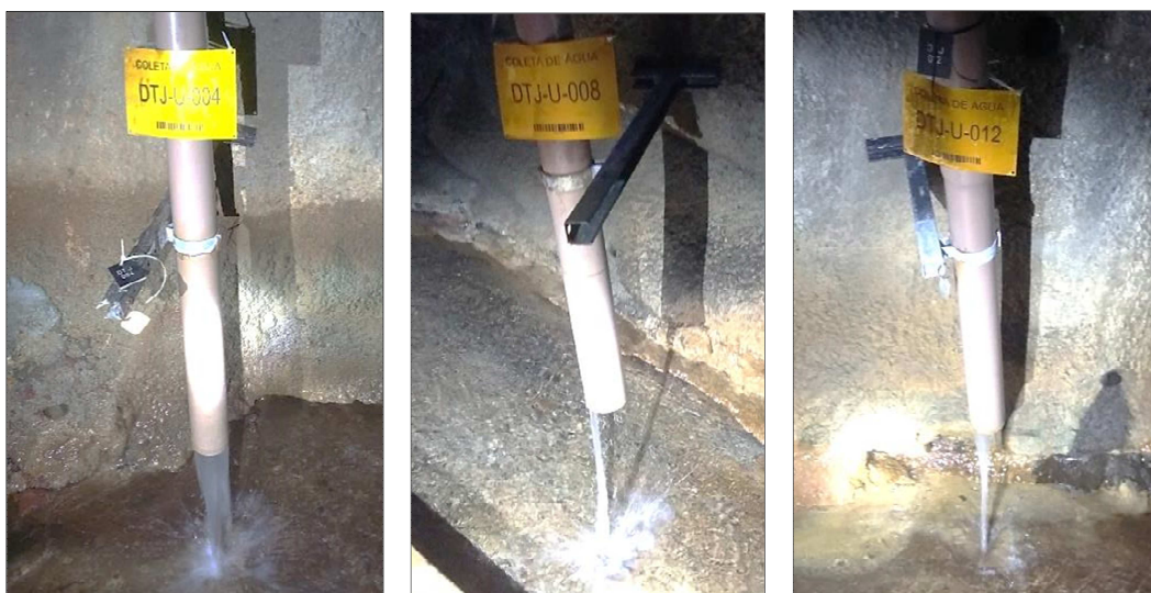
Figura 40 – Deságue dos drenos do concreto de enchimento.
