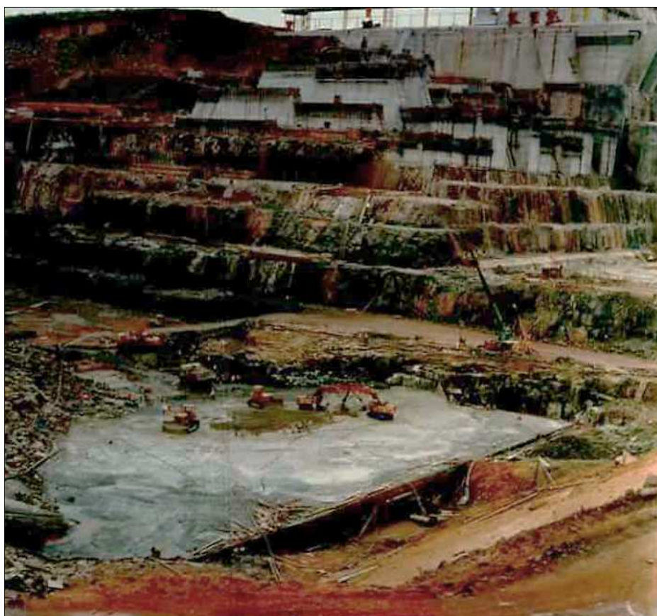
Figura 13 – Lançamento e compactação do concreto de enchimento.
