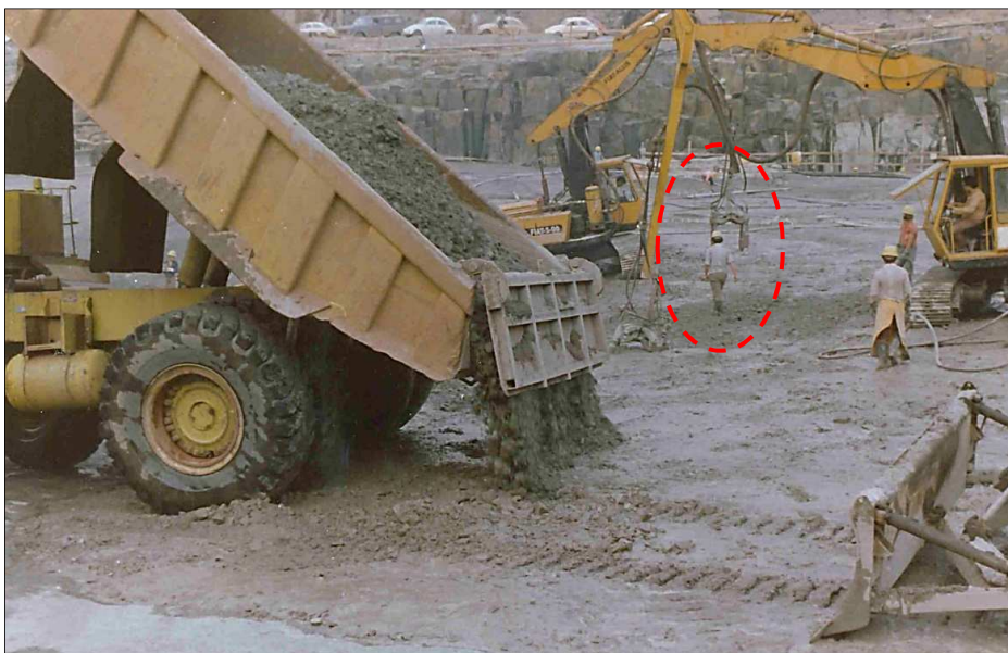
Figura 15 – Equipamentos utilizados na concretagem.
