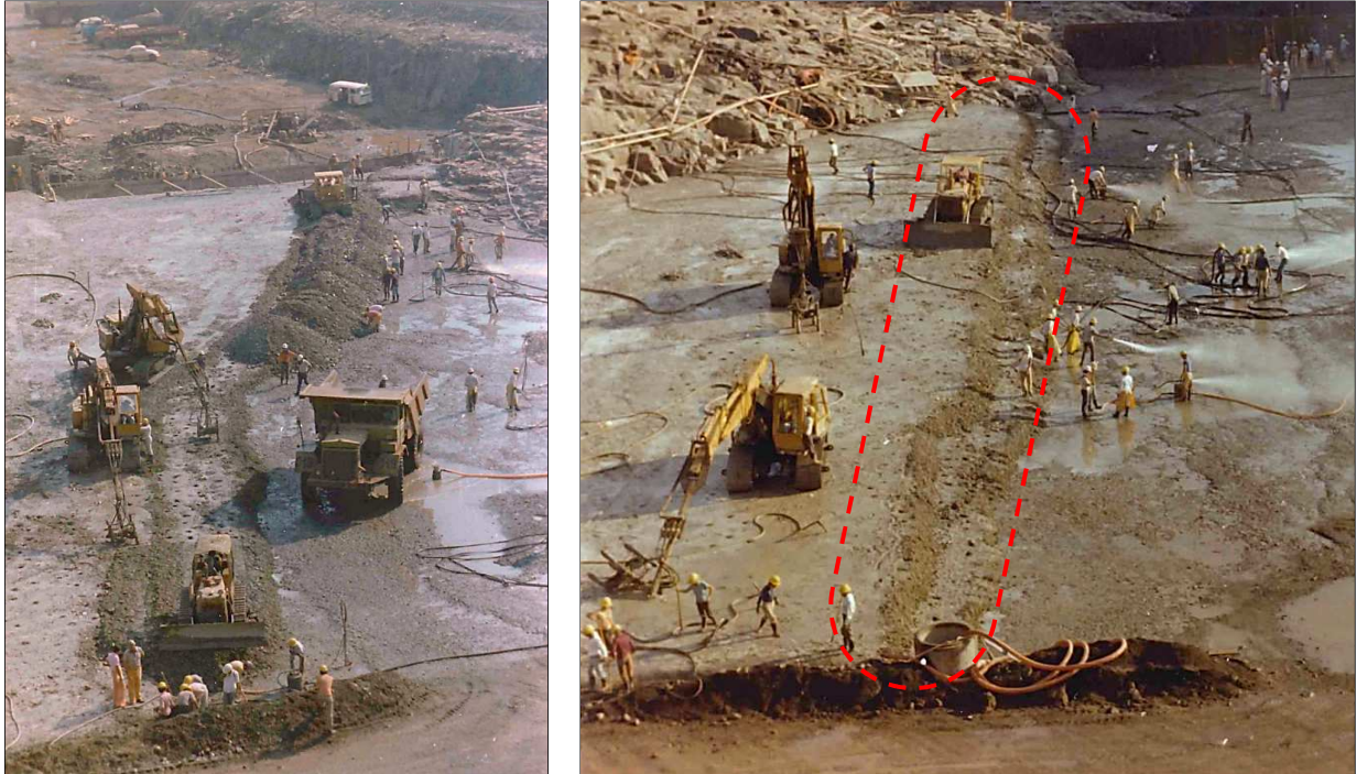
Figura 16 – Concretagem na U-7, El. 43.
