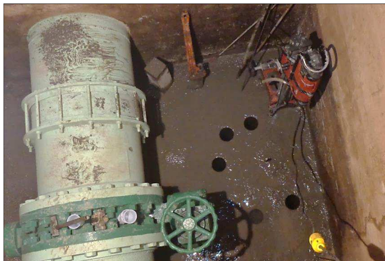
Figura 27 – Extração de testemunhos em andamento.
