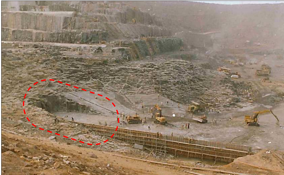
Figura 14 – Primeira camada de concretagem.
