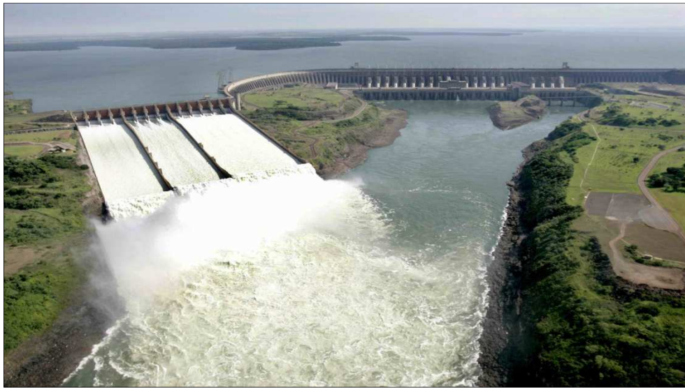
Figura 7 – Vista geral da usina de Itaipu.
