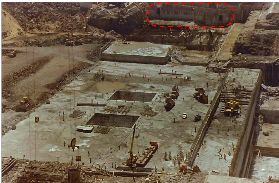
Figura 17 – Fase final de concretagem.
