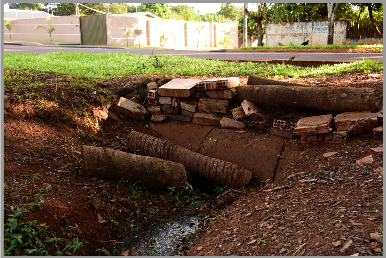
Fotografia 3 – Início da canalização do afluente do rio M'Boicy na rua Martim-Pescador
