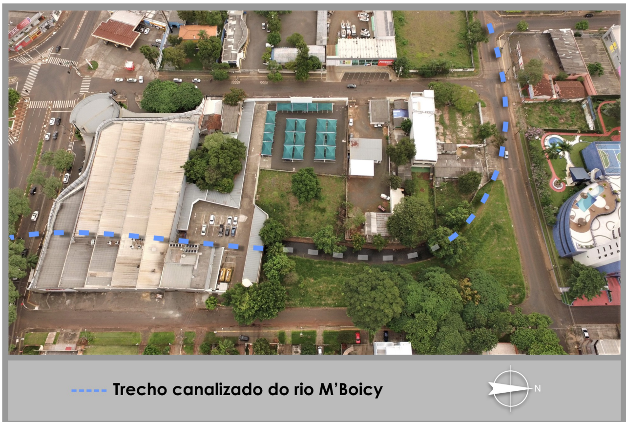
Figura 15 – Canalização de trecho do rio M'Boicy próximo ao supermercado Muffato Boicy.
