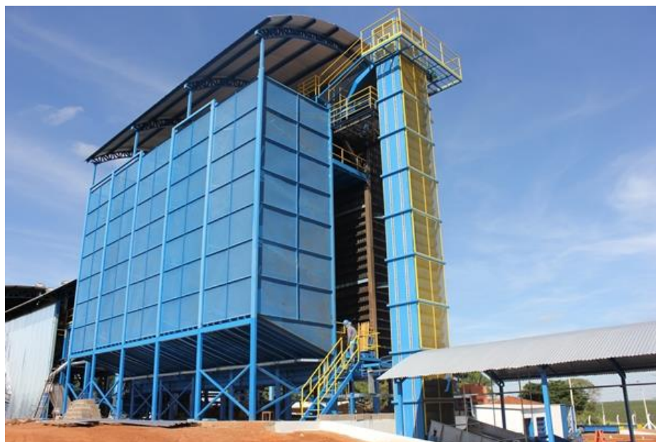
Figura 8 - Silo bin destinado ao armazenamento de frutas.
