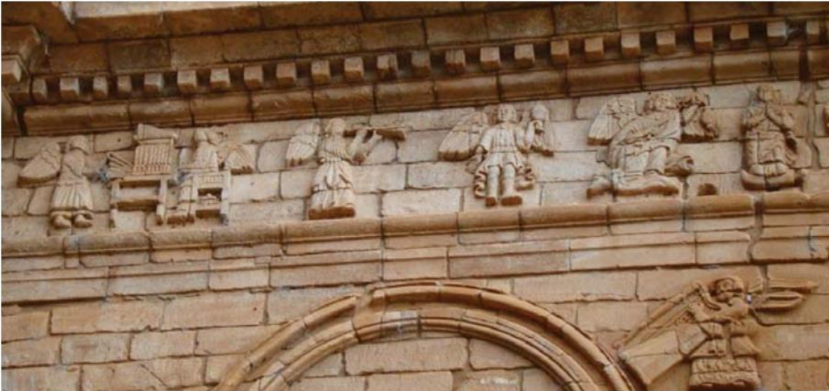
Figura 22 Anjos músicos, friso decorativo, pedra arenítica; ornamentação interior; Igreja de la Trinidad, Paraguai.
