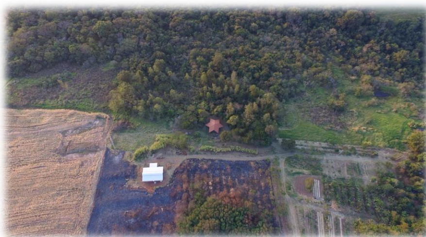
Figura 8: Vista aérea da igreja e da nova casinha de feitió
