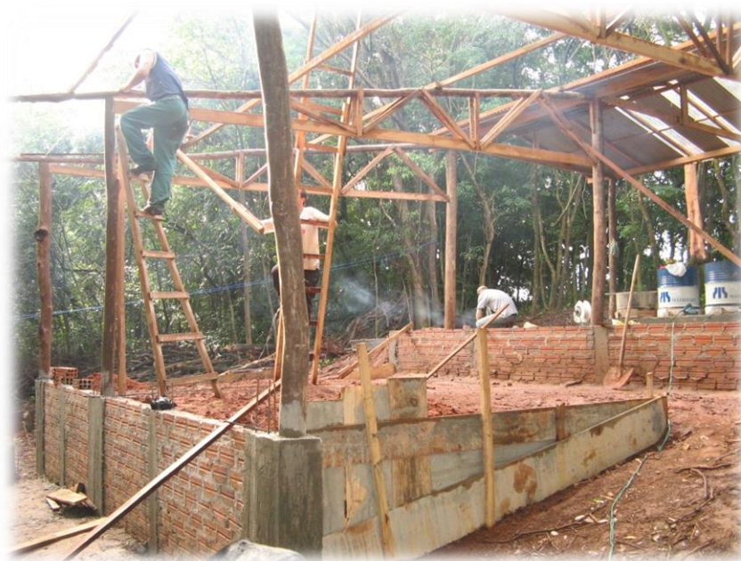
Figura 5: Construção da primeira casinha de feitió
