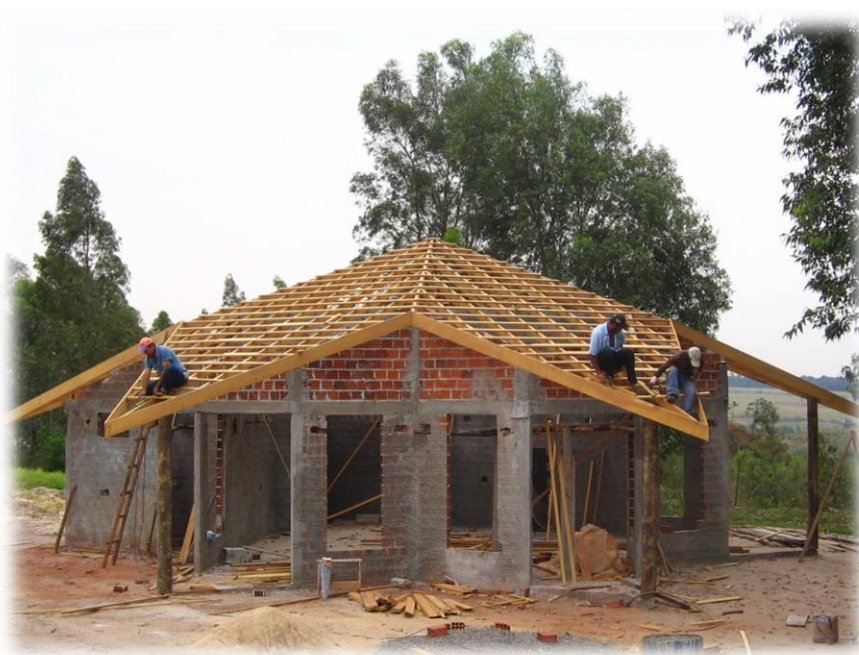
Figura 4: Construção da igreja
