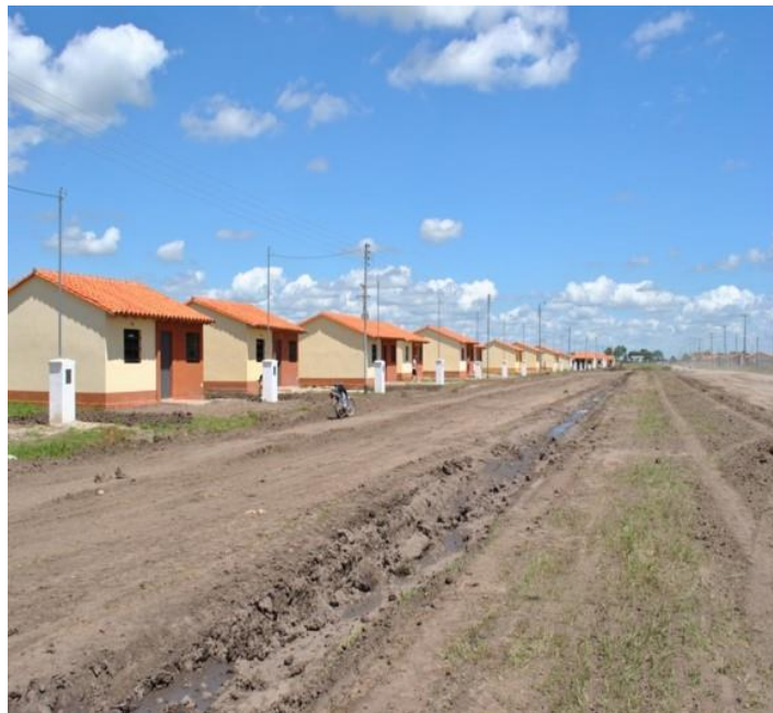
Figura 8 – Antes do Projeto Mercosul Roga: Habitação na comunidade de Villa Paso em Pilar.
