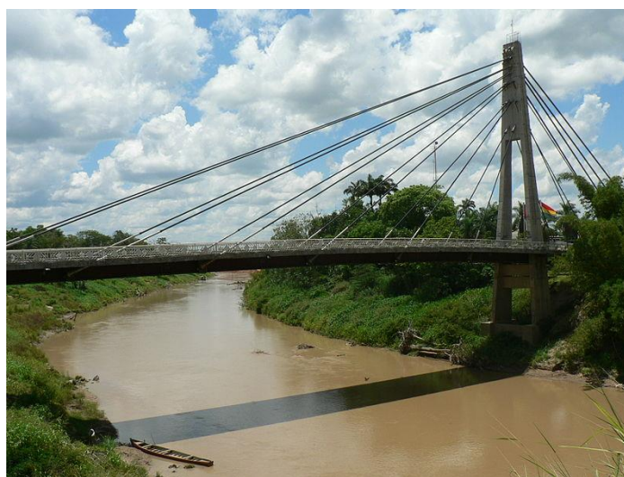
Figura 2. Ponte Binacional Wilson Pinheiro
