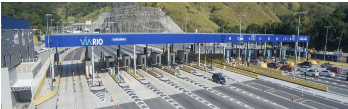
Figura 17 – Praça de pedágio da VIARio S.A.
