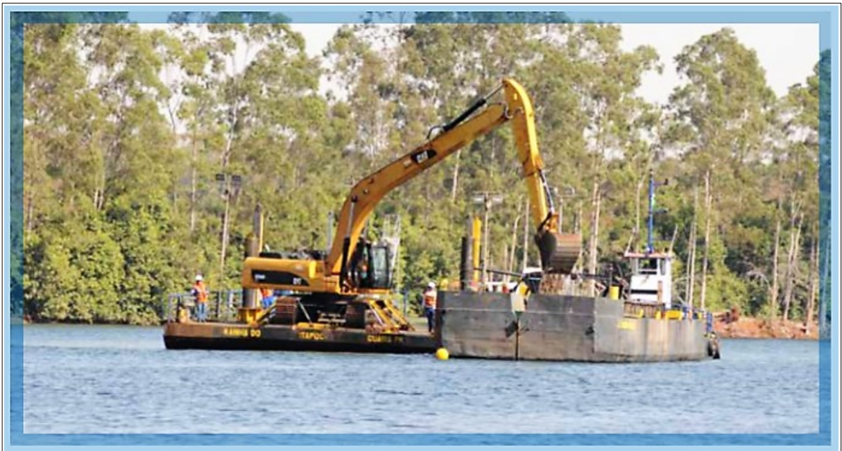
Fotografia 02 – Retirada dos resíduos da explosão de rochas.
