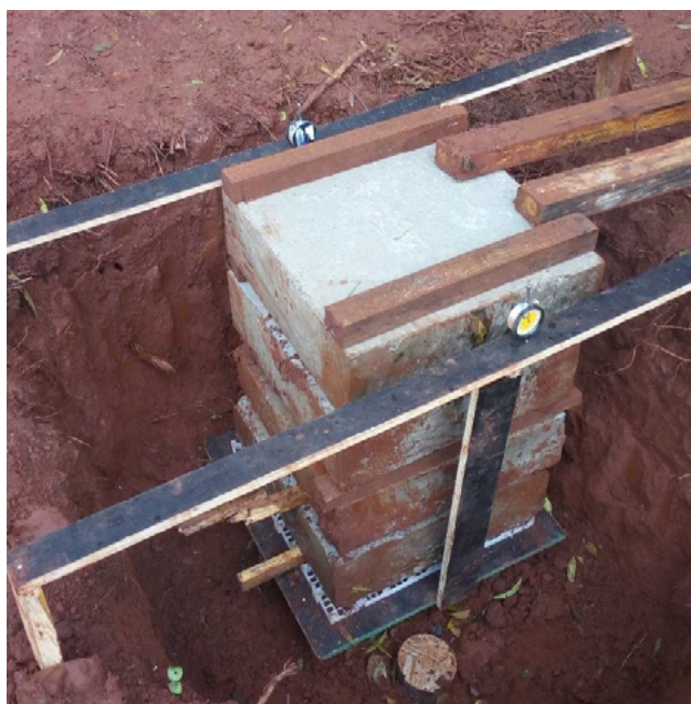
Figura 1 Detalle del ensayo de prueba de carga estática para la estaca de suelo cemento de 12%
