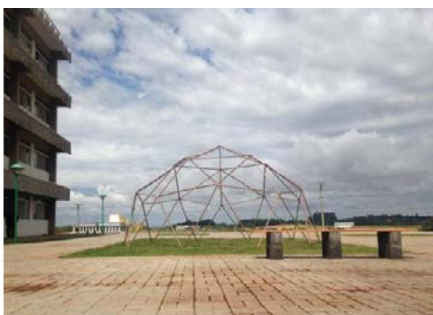
Figura 01 – Cúpula geodésica desenvolvida na disciplina de Canteiro Experimental II do curso de Arquitetura e Urbanismo da UFFS no ano de 2016. Fonte: Zanatta, 2016.
