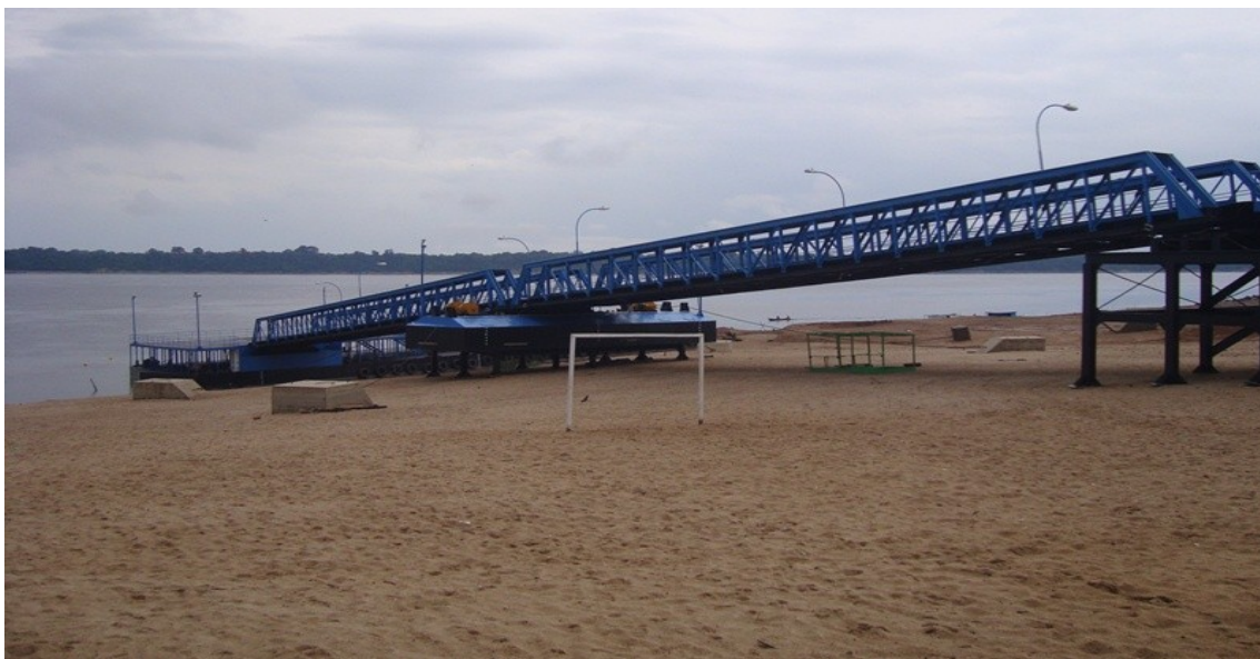
Figura 17 - Terminal hidroviário municipal de Novo Airão.
