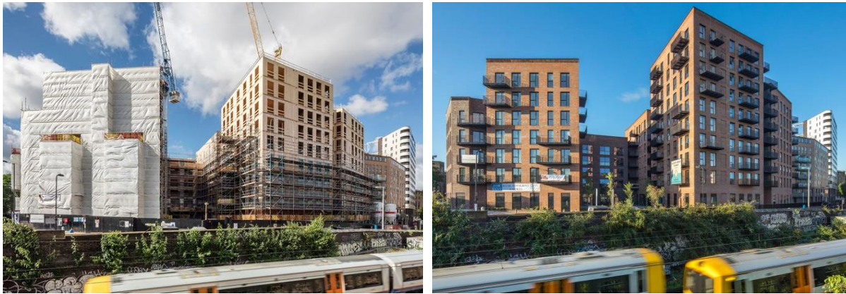
a) Fase de Construcción
