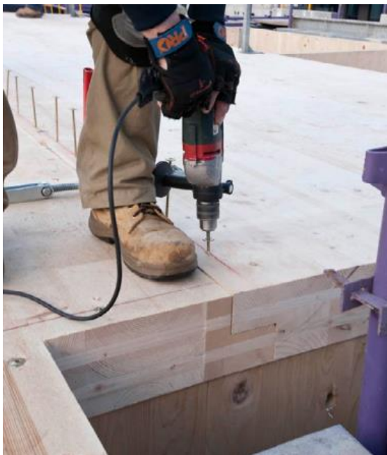
a) Colocación de uniones con tornillos.
