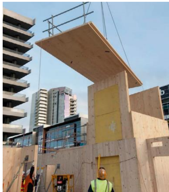
b) Colocación de los paneles por medio de grúa.
