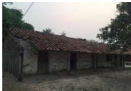
FIGURA 09: Vivienda con doble punilla
