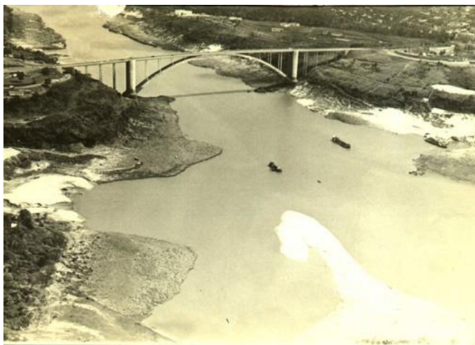
Figura 37: Imagem aérea da Ponte da Amizade. Meados dos anos 1970. Não há dados de fotografo. Fonte: site da Prefeitura Municipal de Foz do Iguaçu.
