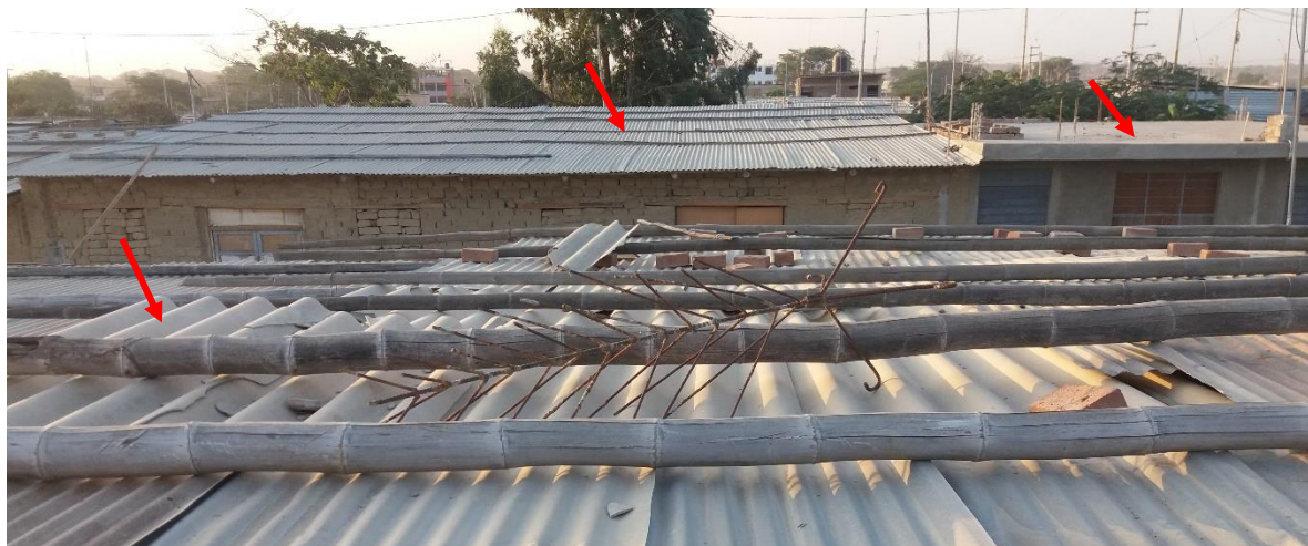
Figura 88 – Techo con calamina, fibrocemento y losa de concreto.
