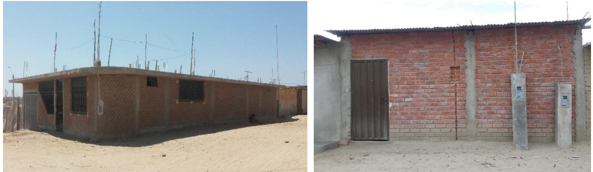
Figura 84 – Paredes de ladrillo.
