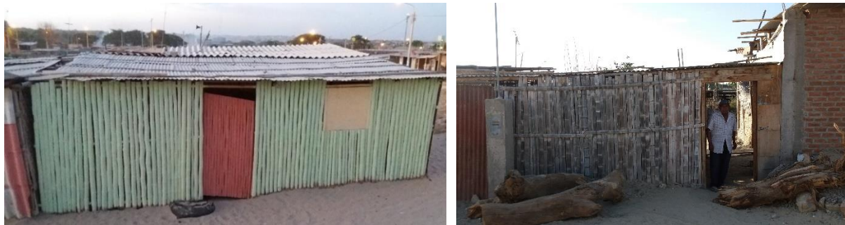
Figura 85 – Paredes de bambú.
