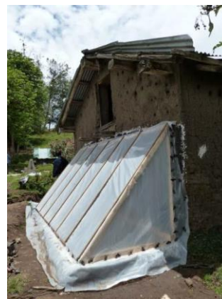
Figura 64 – Instalación del Muro Trombe en el caserío Pucará.
