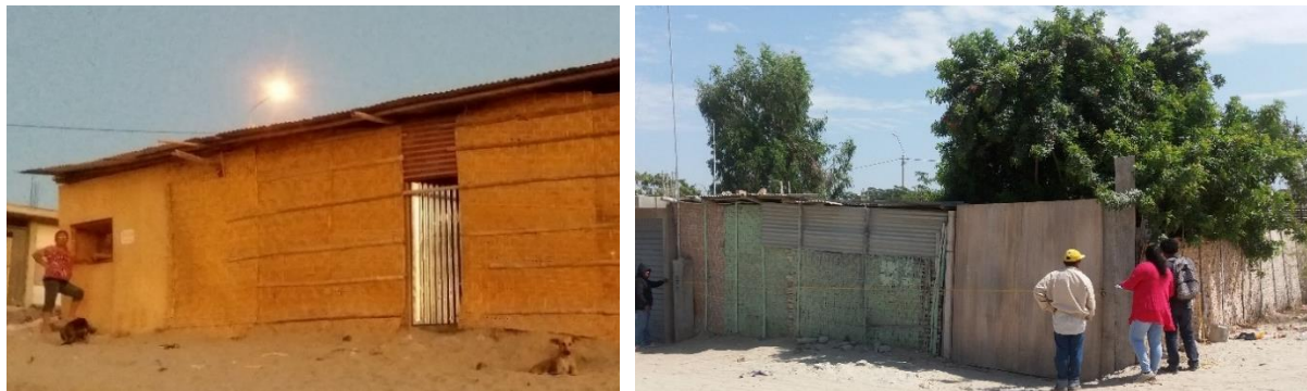
Figura 86 – Paredes de esteras.
