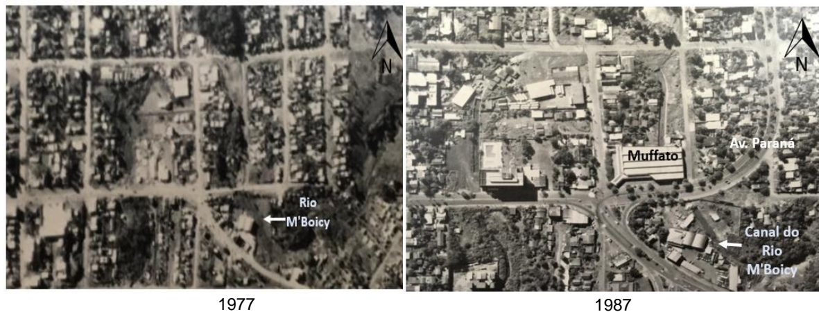
Figura 2: Fotografias aéreas do trecho do Rio M'Boicy
