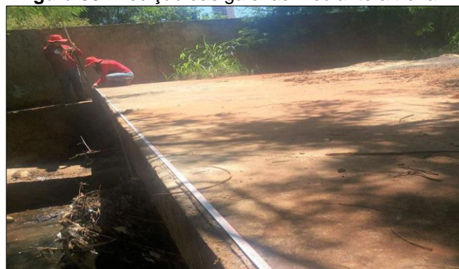
Figura 58: Medição das galerias mediante a trena
