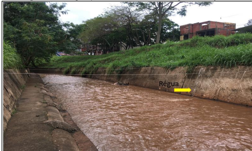
Figura 21: Régua para medir o Nível da água da seção
