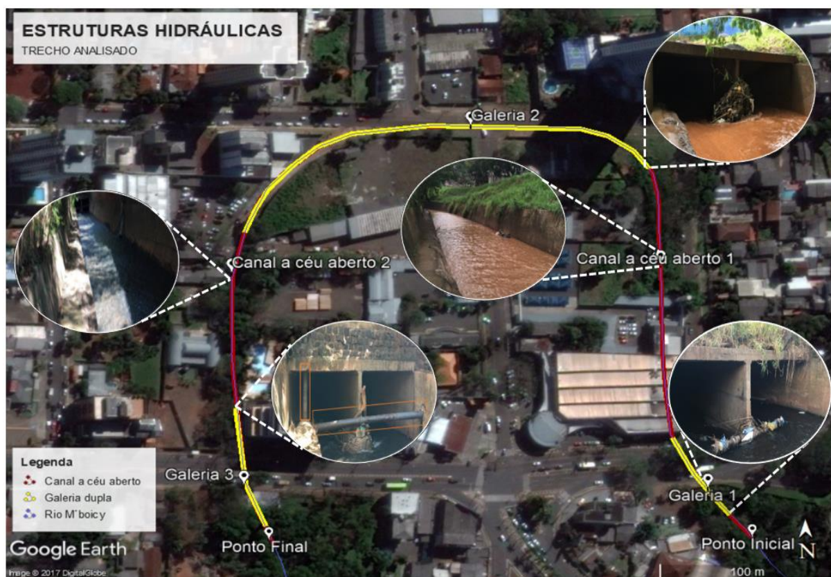
Figura 18: Estruturas hidráulicas do trecho
