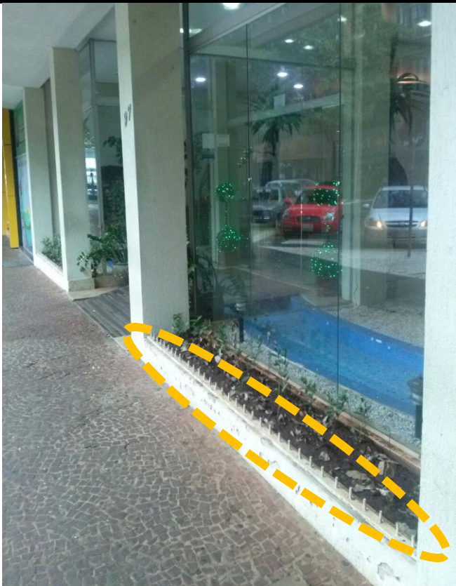
Figura 12: estacas de metal na fachada do Hotel Foz do Iguaçu, em Foz do Iguaçu-PR (KAWAJI, 2016)
