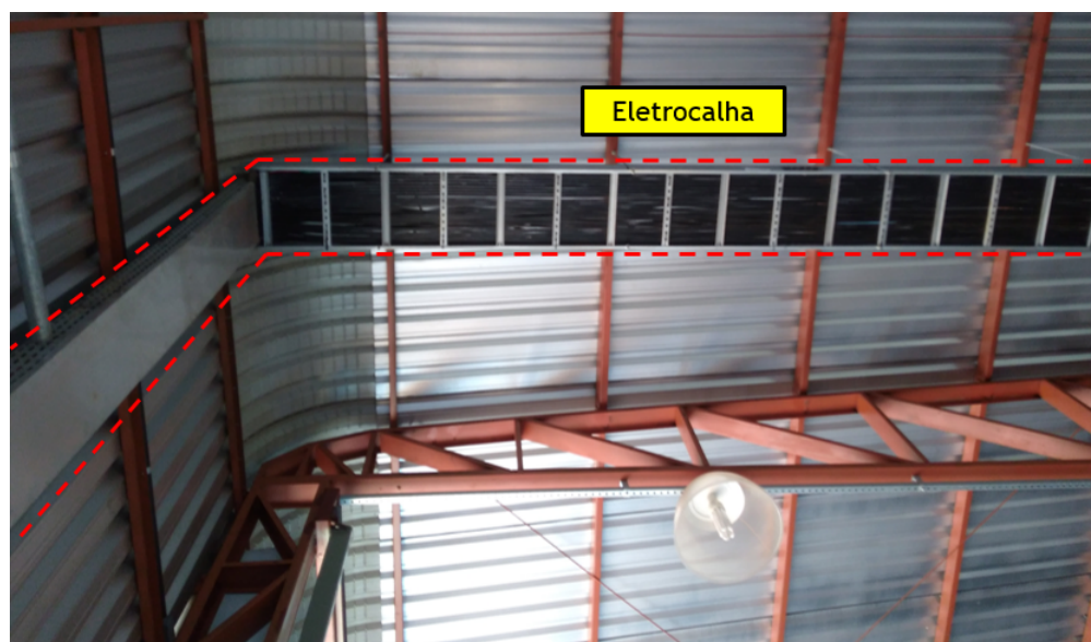
Figura 25 – Encaminhamento dos circuitos de corrente alternada
