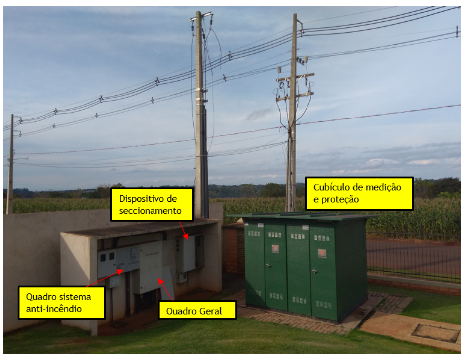
Figura 20 – Entrada de serviço da empresa de fertilizantes
