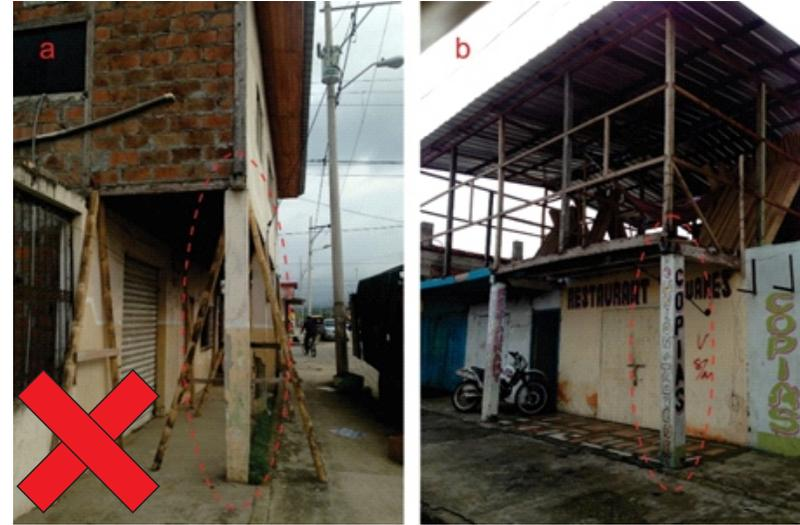
Los pilares estaban mal dimensionados, es decir, eran muy delgados y esbeltos para el peso que debía soportar del piso superior.
