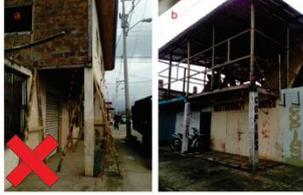
Los pilares estaban mal dimensionados, es decir, eran muy delgados y esbeltos para el peso que debía soportar del piso superior.
