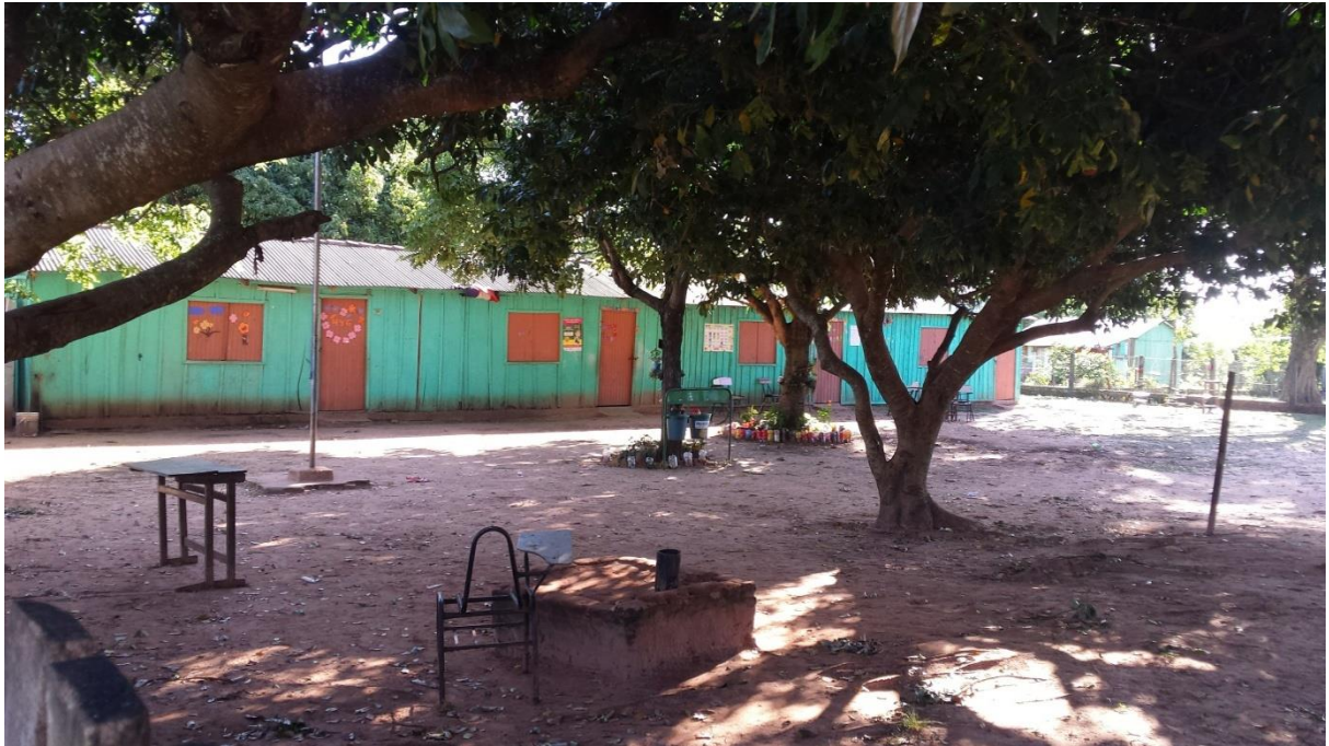
Fotografía 3– Escuela Básica n° 8096, 1 de Noviembre.
