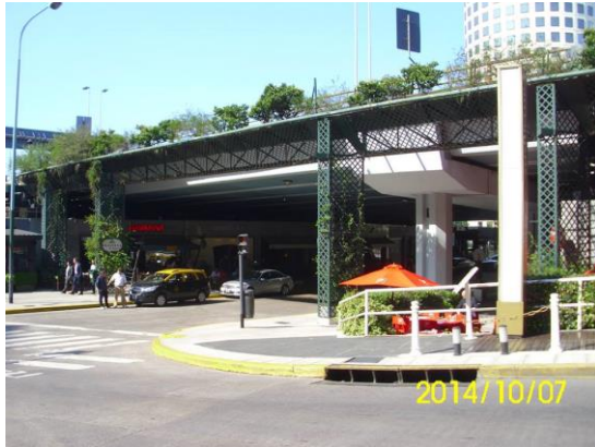
Imagen 1. Viaducto de la avenida 9 de Julio en Buenos Aires- Argentina (Café Havanás - Franquicia Internacional). Fuente: Leonard Freemann.
