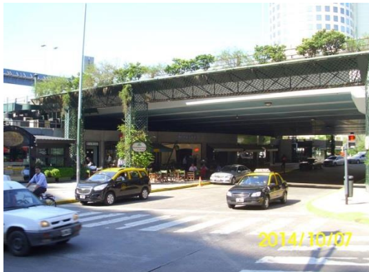
Imagen 2 Viaducto de la avenida 9 de Julio Buenos Aires-Argentina (Variedad de establecimientos comerciales). Fuente: Leonard Freemann.
