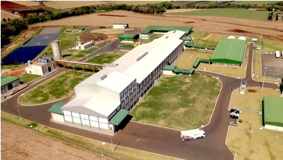
Foto 2 – Planta Frigorífica de la empresa Friella en el Municipio de Itaipulândia
