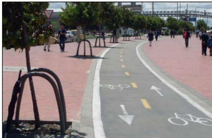
Figura 18 Barreras y señalización en la ciclovia.
