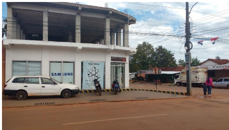
Figura 40 Nuevas construcciones en la Av. 14 de mayo.
