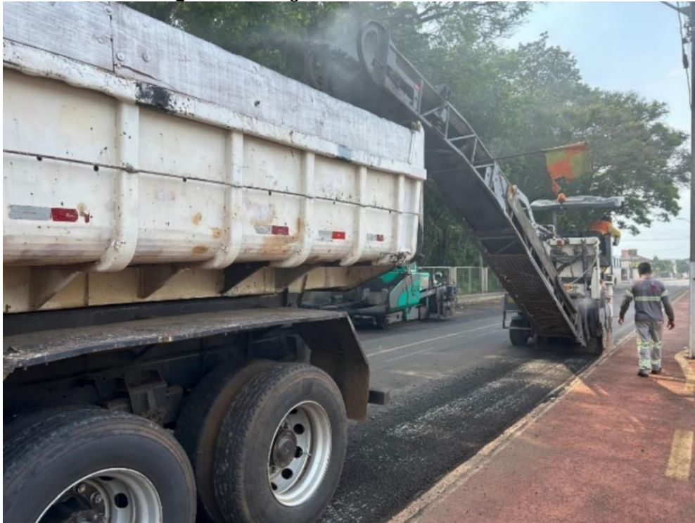
Figura 3. Fresagem do revestimento asfáltico.
