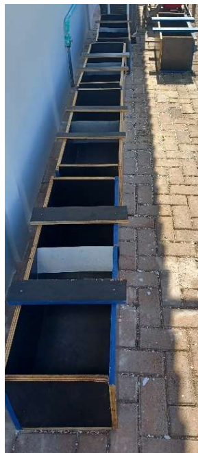
a) Fixação das Chapas de Zinco
