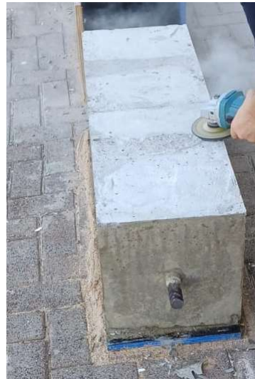
Figura 12: Aplainação das Vigas
