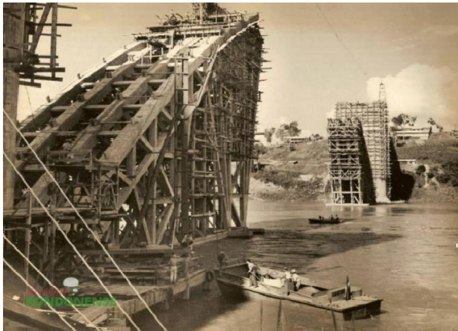
Figura 1 – Construção da Ponte da Amizade
