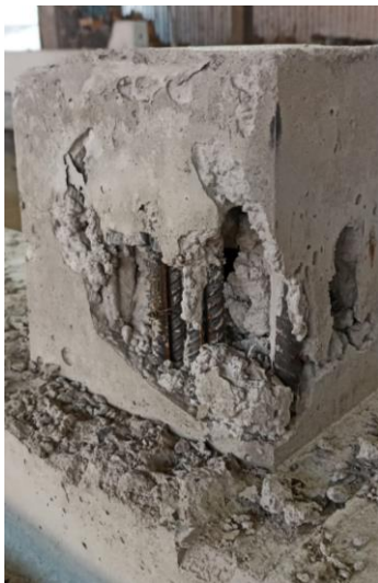
Figura 7 - Peça pré-moldada com nicho de concreto
