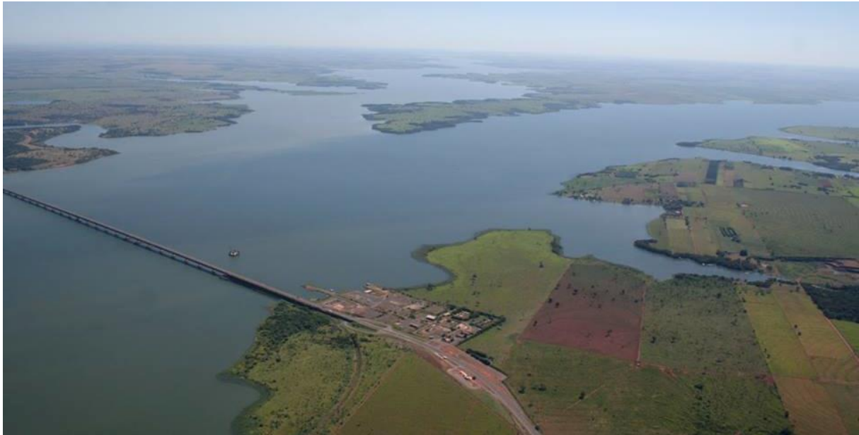
Figura 3 - Vista aérea da Ponte Rodoferroviária Rollemberg-Vuolo, que liga os estados de São Paulo e Mato Grosso do Sul sobre as águas do Rio Paraná, sendo essa área alagada além do leito original devido ao represamento pela Hidrelétrica de Ilha Solteira. 4
